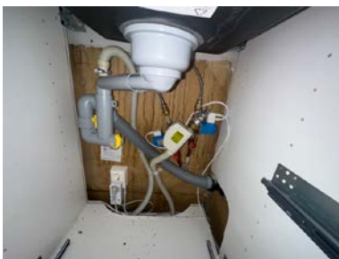
Røropplegg i kjøkkenbenk med Waterguard
