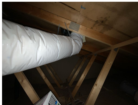
Kontroll rundt rørgjennomføringer.
