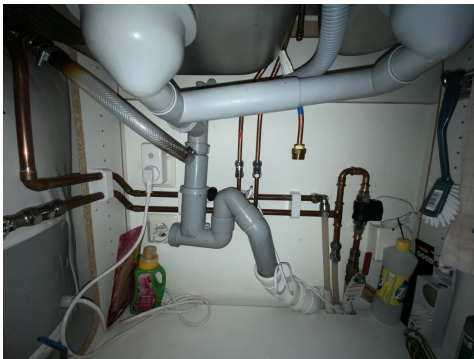
Besiktigelse av røropplegg.
