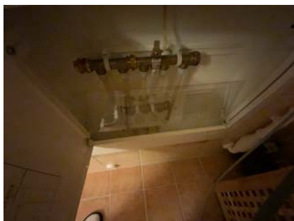
Besiktigelse av røropplegg.
