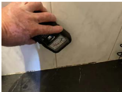
Undersøkelsen i vegg overflate dusj viser ingen tegn til fukt.
