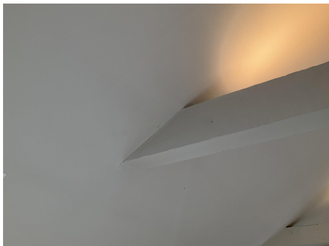
Takbjelker ført i gjennom takkonstruksjonen.
