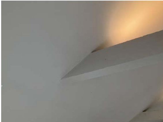
Takbjelker ført i gjennom takkonstruksjonen.
