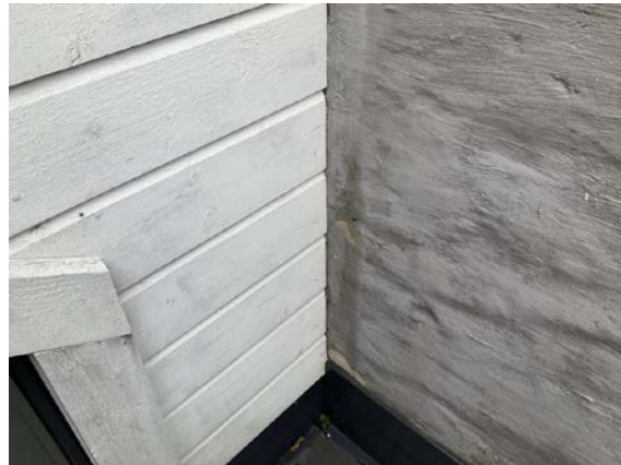
Avflassing på murpuss.
