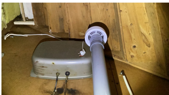
Ventilering av avløp
