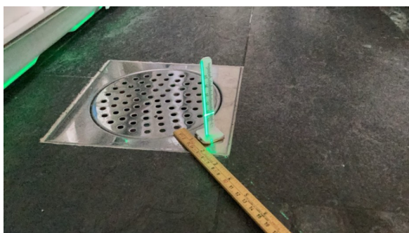
Måling ved sluk
