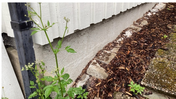
Grunnmur i lettklinker på tilbygg
