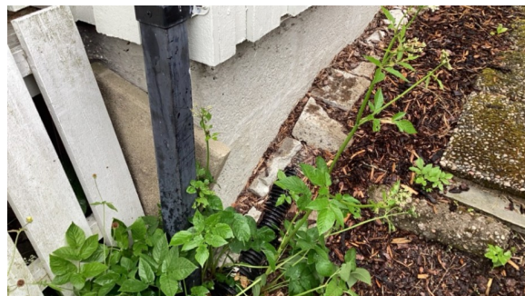
Drensrør ved tilbygg
