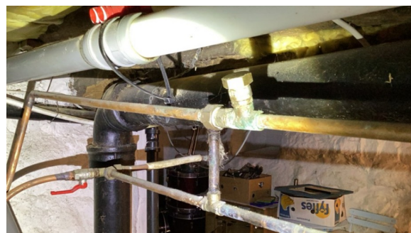
Vannmåler og stoppekran
