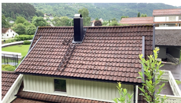
Taket har ikke snøfangere
