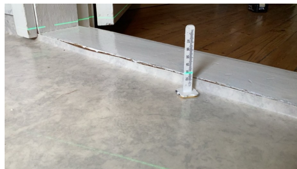
Måling ved terskel
