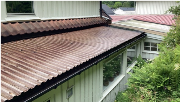
Tekking av plater i metall
