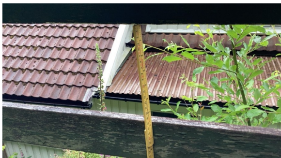
Åpning er større enn dagens krav
