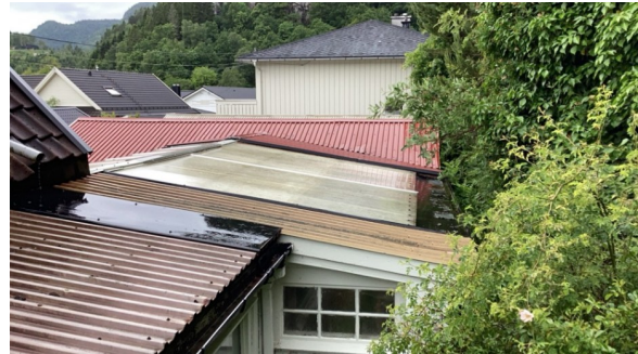
Tekking av glassplater
