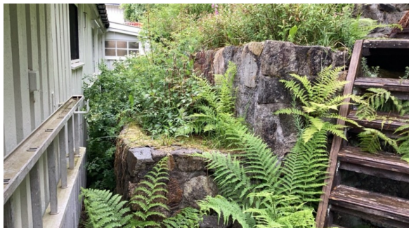
Forstøtningsmur bak bolig
