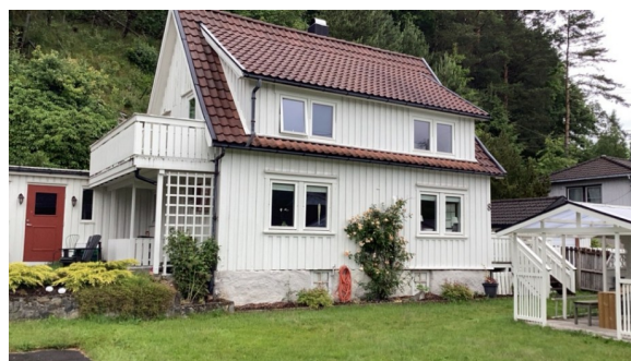
Taket har ikke snøfangere
