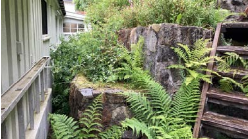
Forstøtningsmur bak bolig
