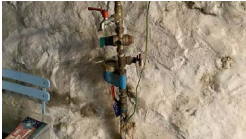
Irr på rør
