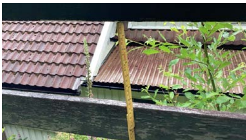
Åpning er større enn dagens krav
