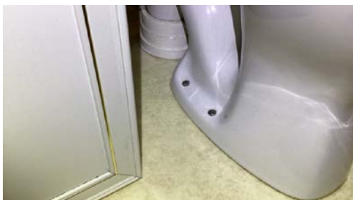
Innfesting på toalett mer montert direkte gjennom belegget
