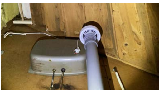
Ventilering av avløp
