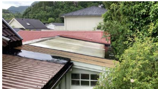
Tekking av glassplater
