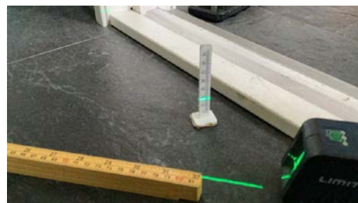
Måling 80 cm fra sluk og ved terskel
