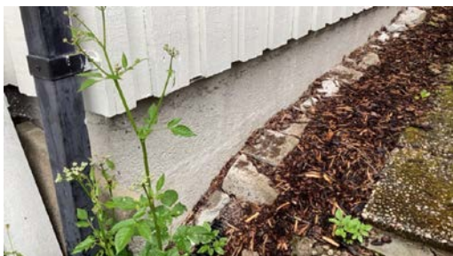
Grunnmur i lettklinker på tilbygg
