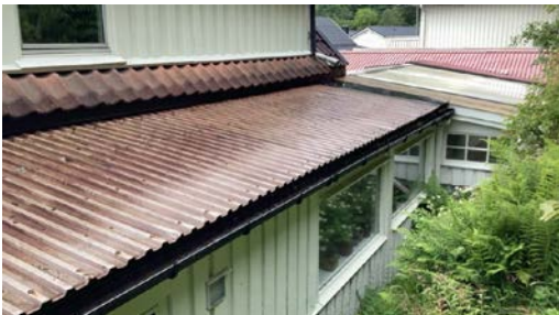
Tekking av plater i metall
