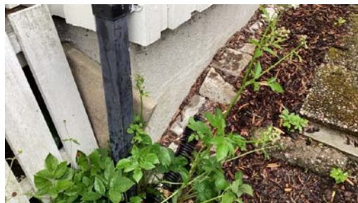
Drensrør ved tilbygg
