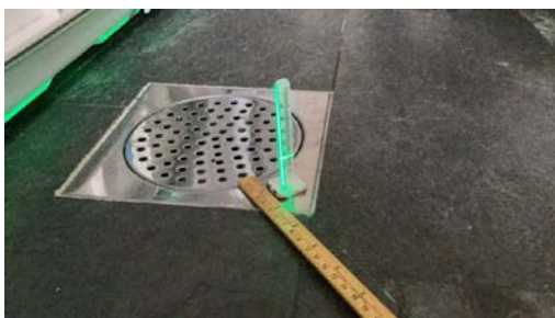
Måling ved sluk
