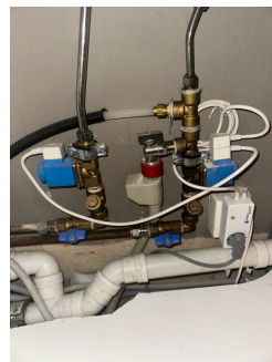
Rørapplegg i kjøkkenbenk med Waterguard
