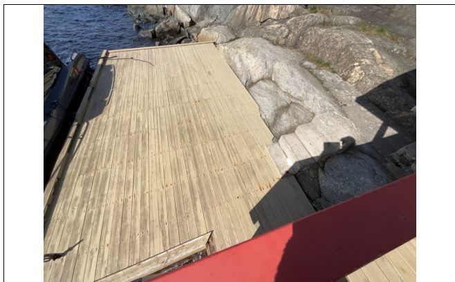
Del av brygge på eiendommen.
