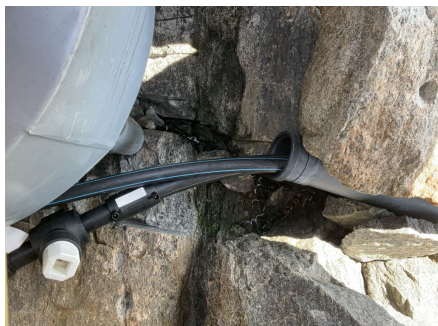
Rør til avløp og vann.
