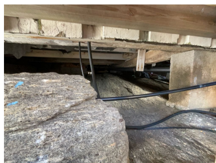
Pilar. Del av grunnmur.
