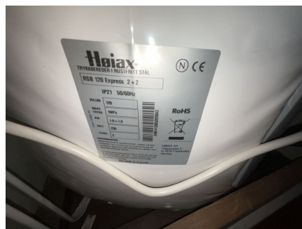
Beskrivelse på varmtvannstank.
