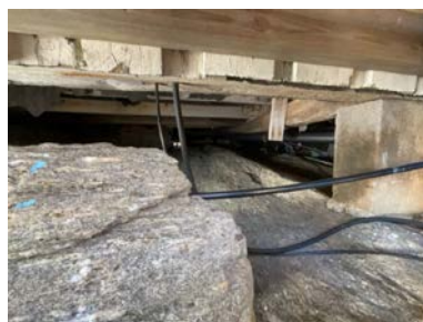
Pilar. Del av grunnmur.
