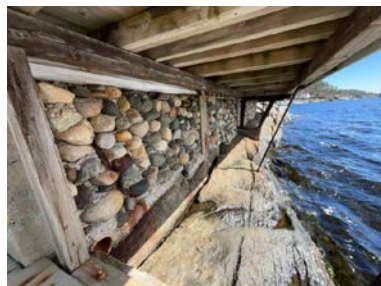
Pilar. Del av grunnmur.
