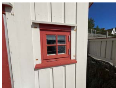
Eksempel på vindu i yttervegg.
