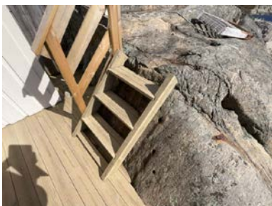
Trapp fra terrasse til terreng.
