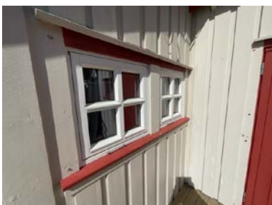
Eksempel på vindu i yttervegg. Dette er noe nyere vinduer.
