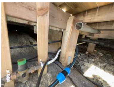
Del av grunnmur. Pilar.
