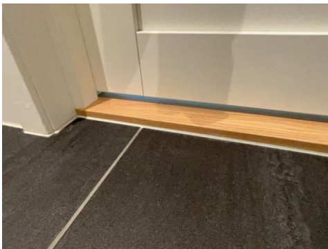
2. ETASJE > BAD/TOALETTROM I 2. ETASJE
