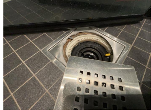
2. ETASJE > BAD/TOALETTROM I 2. ETASJE
