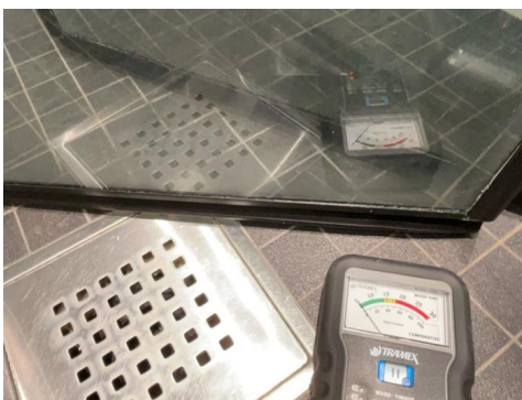
1. ETASJE > BAD/TOALETTROM I 1. ETASJE
