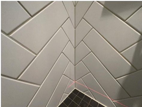
2. ETASJE > BAD/TOALETTROM I 2. ETASJE
