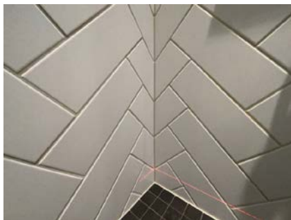
2. ETASJE > BAD/TOALETTROM I 2. ETASJE
