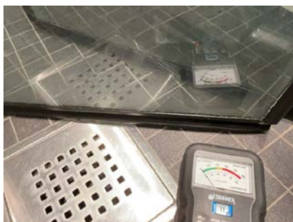
1. ETASJE > BAD/TOALETTROM I 1. ETASJE
