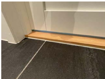
2. ETASJE > BAD/TOALETTROM I 2. ETASJE
