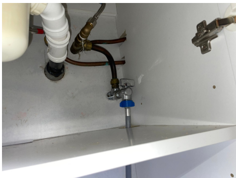
Eksempel på irr på rør
