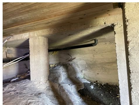
Avløpsrør i tilbygget krypkjeller
