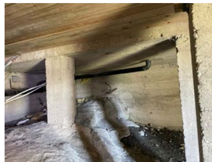
Avløpsrør i tilbygget krypkjeller
