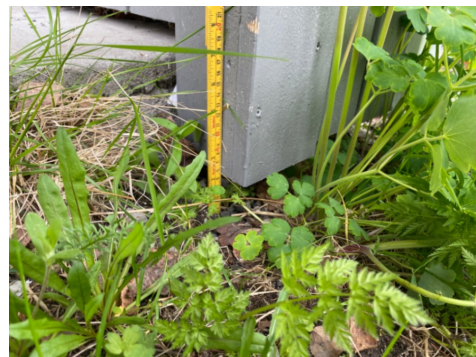
Kledningsbord bør ha minst 300 mm avstand til terreng for å unngå skader og misfarging fra vannsprut opp fra terrengoverflaten
