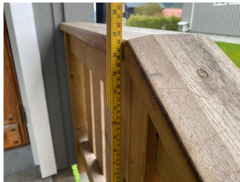
Høyde rekkverk ca. 90 cm.
