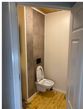
Drensåpning mangler fra vegghengt toalett
