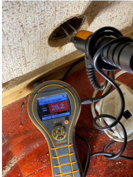
Fuktmåling foretatt med Protimeter MMS2 med pigger mot bunnsvillen mot ytterveggen
