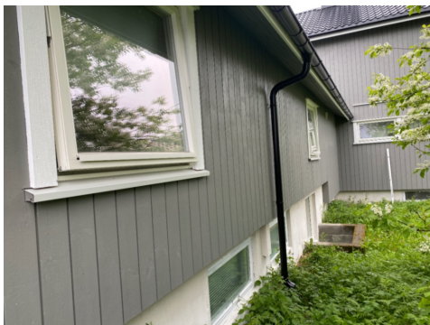
Stående kledning fra 2018/2019.
