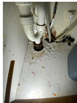
Fuktskader i skrog under utslagsvask.
