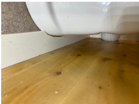
Drensåpning mangler fra vegghengt toalett
