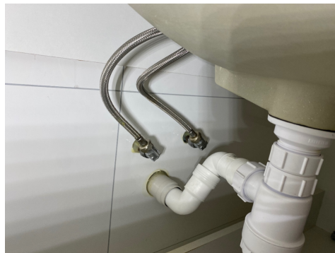
Kontroll av rørgjennomføringer. Tetting med silikon rundt rørgjennomføringer.
