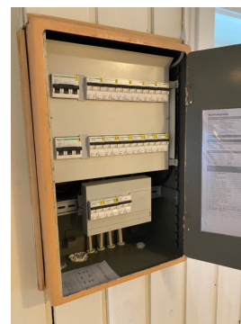
Sikringsskap med automatsikringer, plassert i gangen for hovedetasjen.
