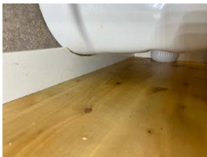
Drensåpning mangler fra vegghengt toalett
