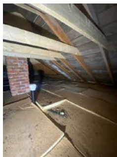
Konstruksjonen er forsterket med hanebjelker i 2018.
