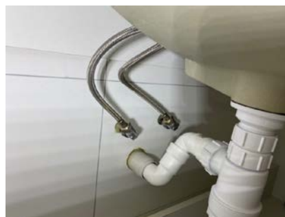
Kontroll av rørgjennomføringer. Tetting med silicon rundt rørgjennomføringer.
