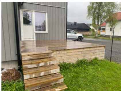
Trapp til terrasse.
