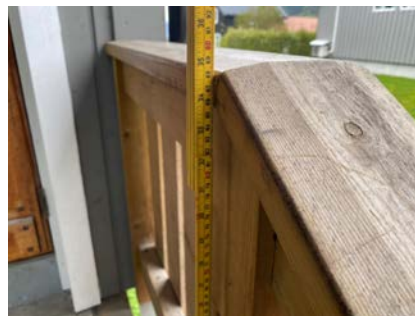
Høyde rekkverk ca. 90 cm.
