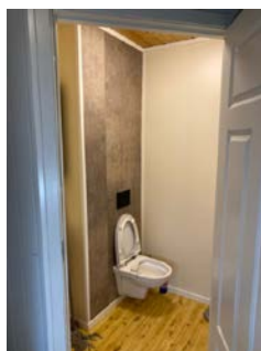
Drensåpning mangler fra vegghengt toalett
