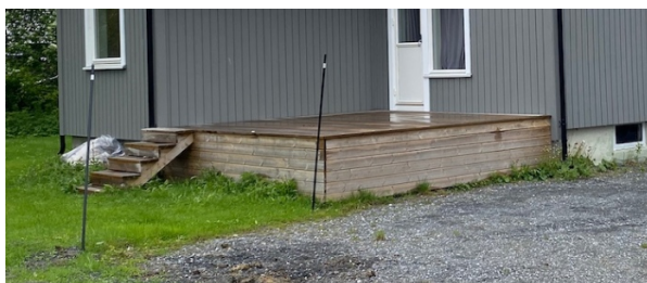
Terrasse med utgang fra stue.
