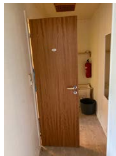
Dør mellom bad og gang, kjellerleilighet.
