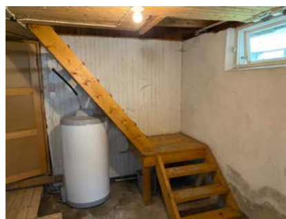
Trapp mellom kjeller og hovedetasjen
