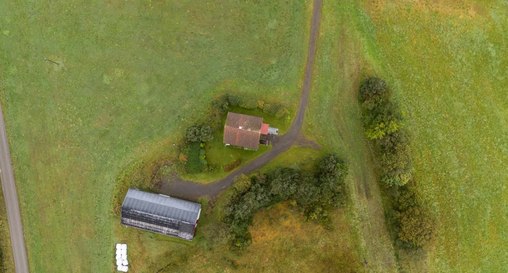
Dronebilde over eiendommen.
