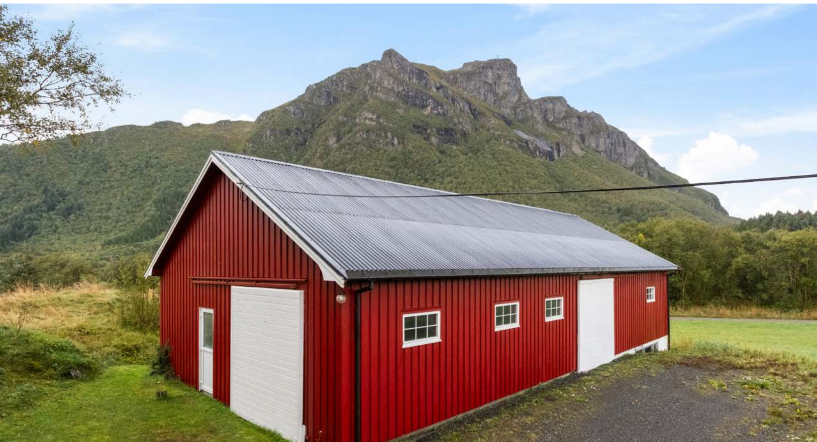
Garasjebygg fra 1993 med stålplatetak og innlagt strøm.
