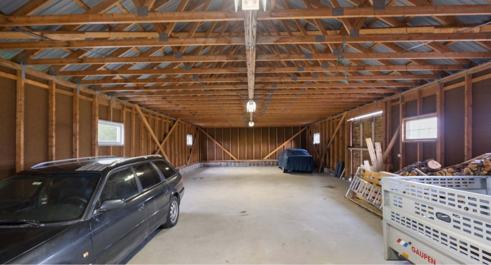
Innvendig har garasjen åpent bindingsverk og god oppbevaringsplass.
