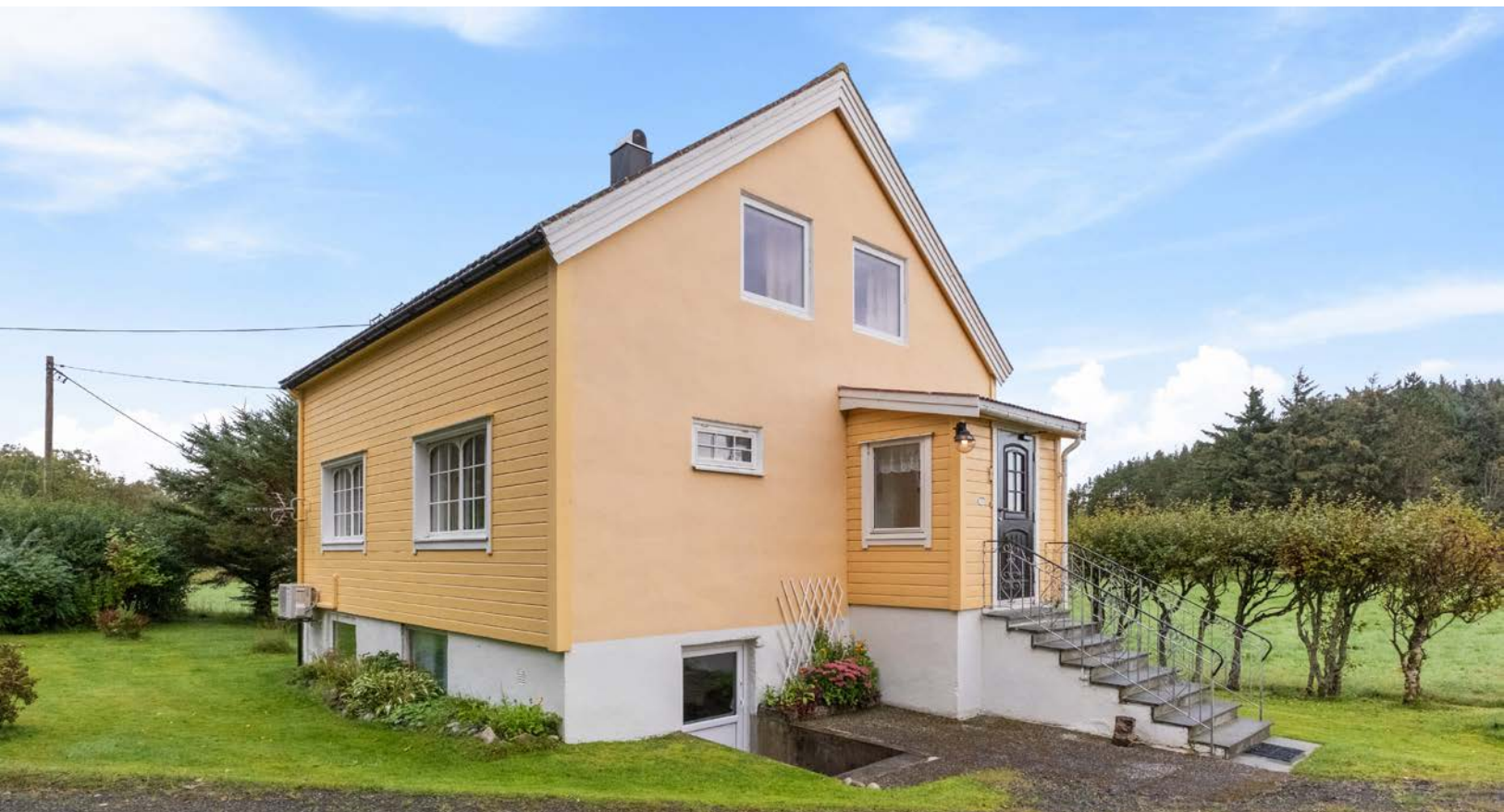
Bygningen er oppført med utvendig liggende trekledning og malt mur på kjellermurene.
