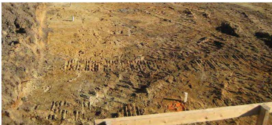
Eksempel på ferdig uttrauet flate som er klar for montering av standard fundament
