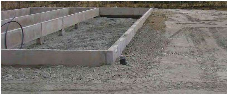
Ferdig tilbakefylt standard ringmursfundament
