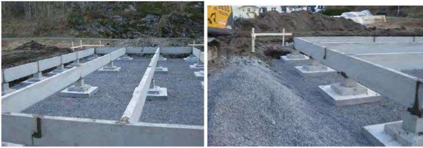
Eksempel på ferdig montert ringmursfundament (GP3) med redusert fundamentstype på f.eks. tørrskorpeleire utført av Ålvsbyhus
