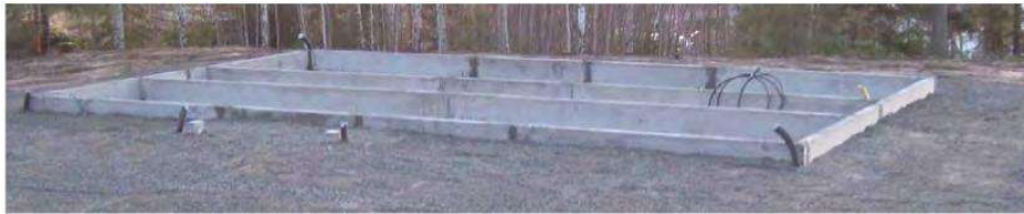
Ferdig tilbakefylt ringmursfundament
