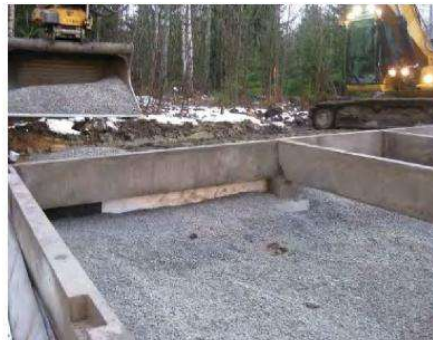
Bilde viser tilbakefylling inntil og inni ringmursfundament.
