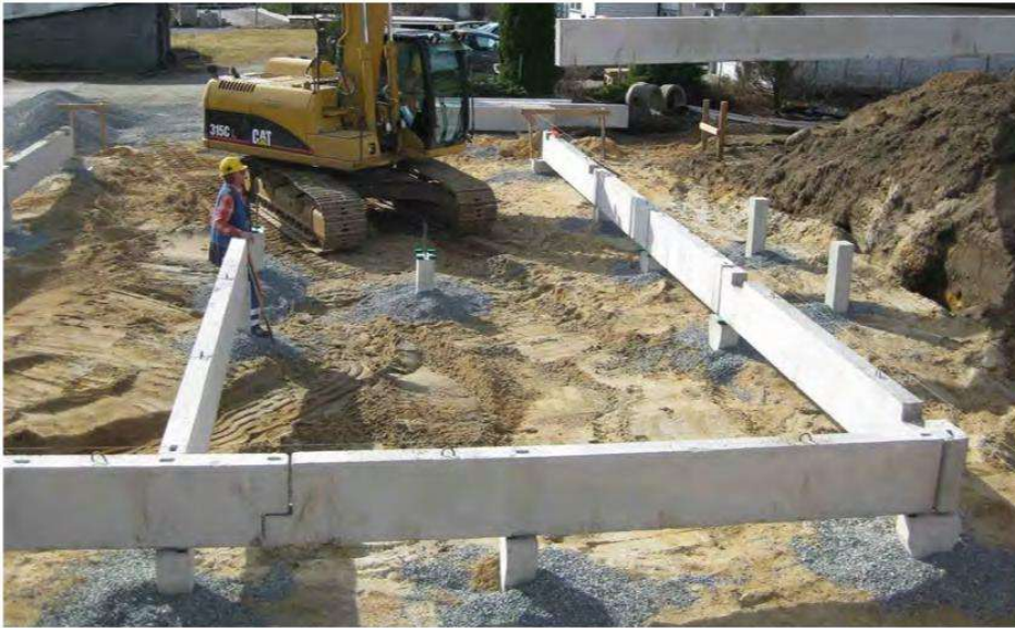
3 bilder som viser montering av ringmursfundamenter
