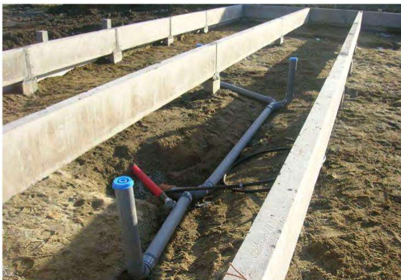
Bilde viser rørfordeling som er klar til å fylles over
