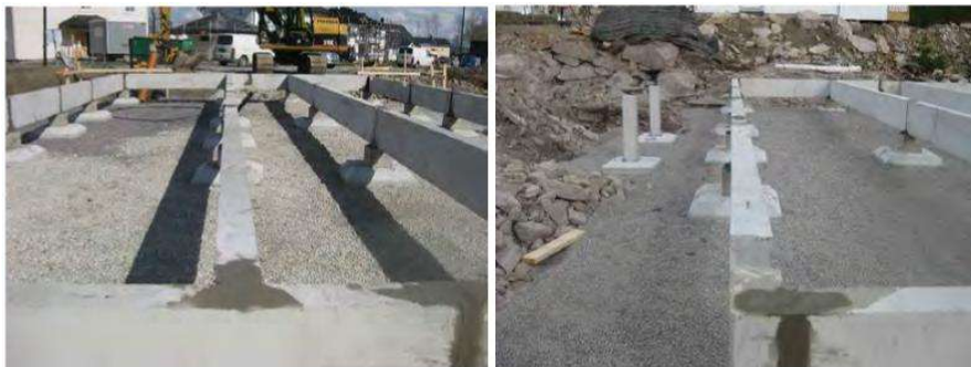
Eksempel på ferdig montert ringmursfundament med redusert fundamentstype på fjell utført av Ålvsbyhus
