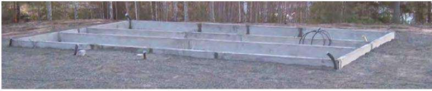
Ferdig tilbakefylt ringmursfundament
