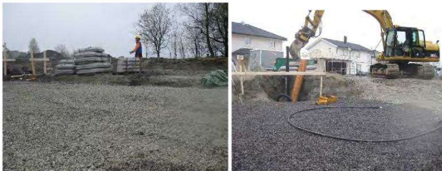
Eksempel på ferdig avrettet flate som er klar for montering av redusert fundamentstype på fjell.
