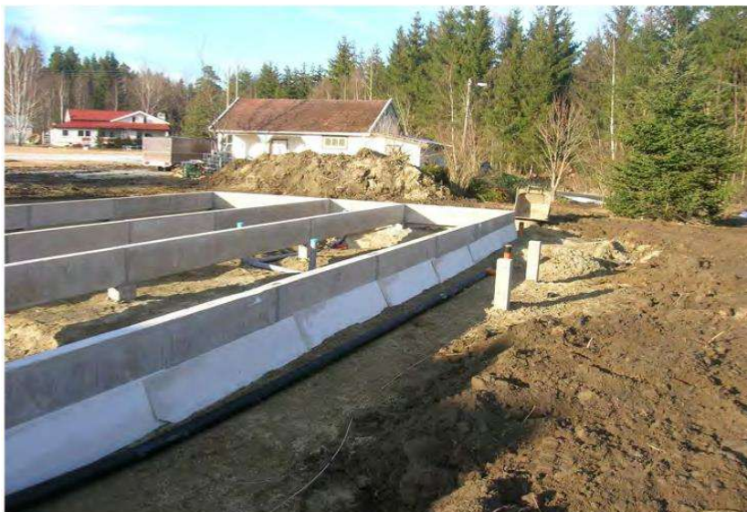
Bilde viser montert rasskydd og bortledning av takvann
