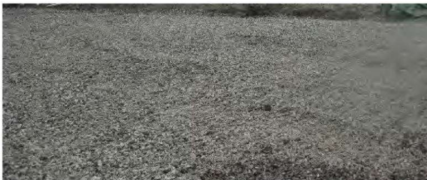
Eksempel på ferdig avrettet flate som er klar for montering av redusert fundamentstype på f.eks. tørrskorpeleire.
