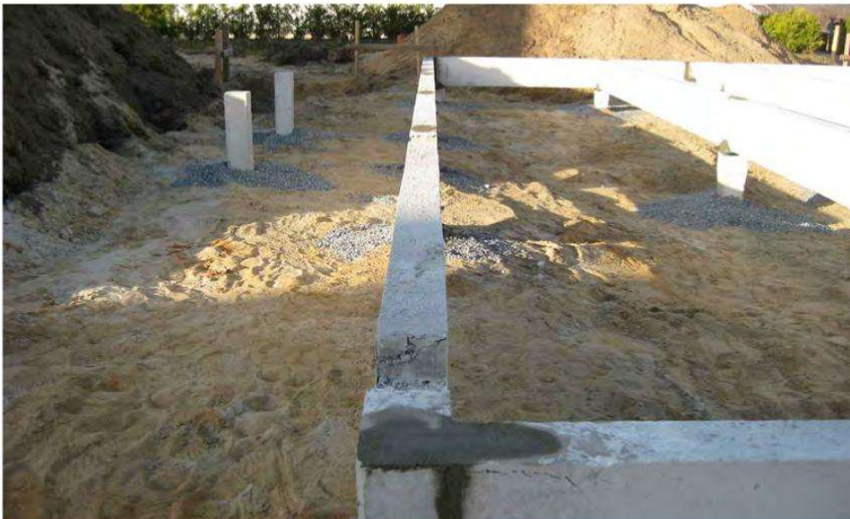
Eksempel på ferdig montert ringmursfundament med standard fundamentstype utført av Älvsbyhus
