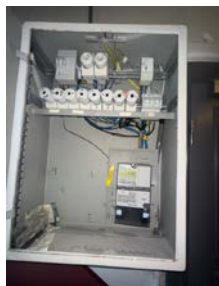
Sikringskap med automatsikringer.
