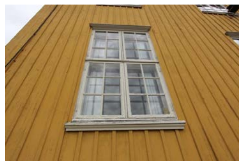
Vinduer registrert av variert type og alder.
