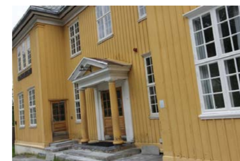
Utvendige malte fasader.
