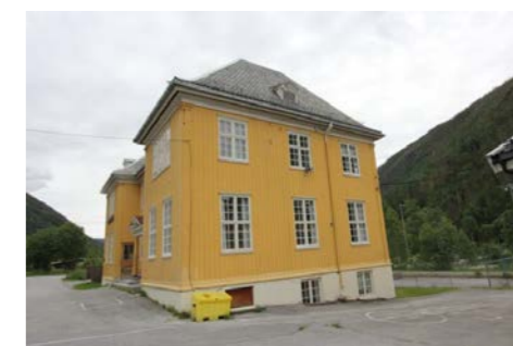
Utvendige malte fasader.
