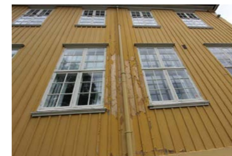
Utvendig vegg fasader
