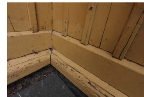
Trebrett med overgang til kledning.
