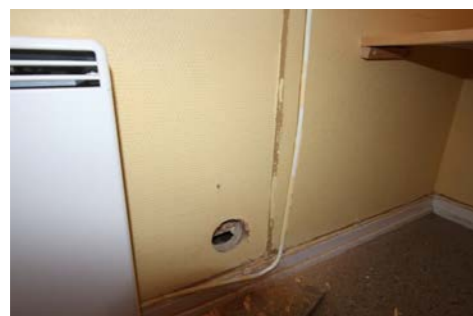
Hulltaking i vegg klasserom kjeller.
