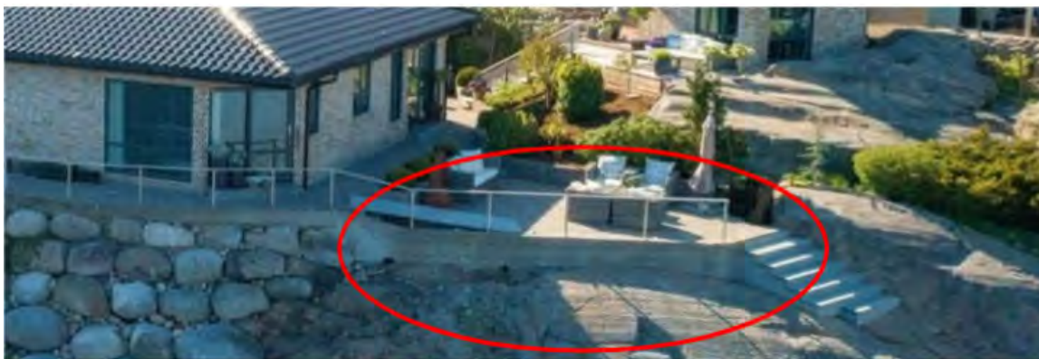
Bilde 9 – Skjermdump av salgsbilde fra 2019 som viser forstøtningsmur og belegningsstein ut fra fasade mot nordøst.
