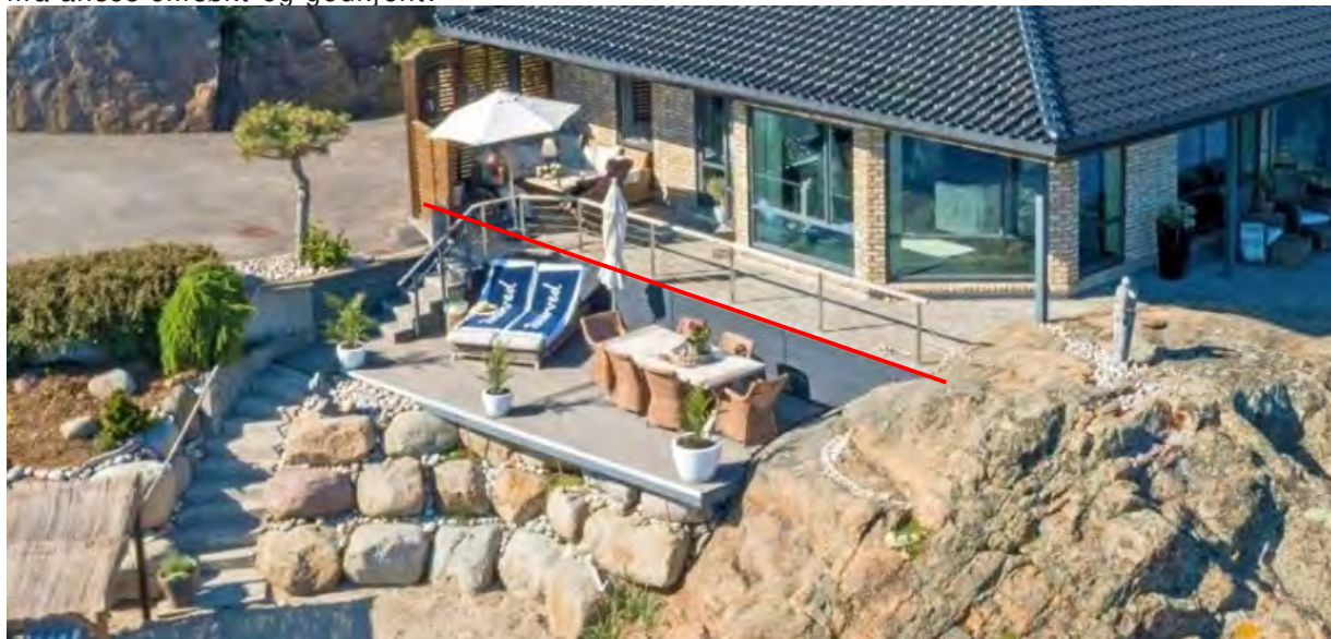
Bilde 8 – Skjermdump av salgfoto fra 2019 med markering av skille mellom hva vi anser omsøkt og godkjent, og hva som må vurderes opp imot SAK03 § 5.
