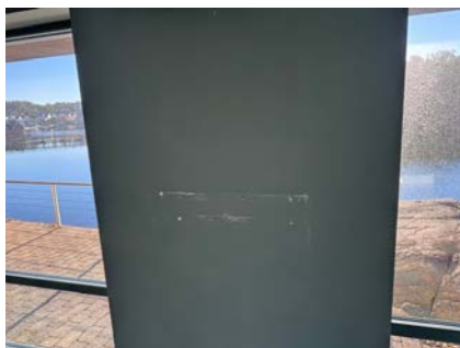
merke vegg stue
