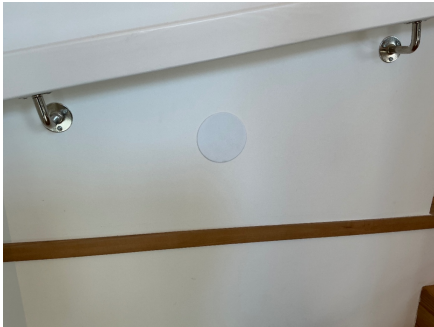
Hull ble plombert med plastlokk.
