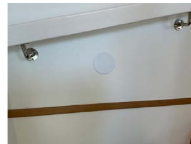
Hull ble plombert med plastlokk.
