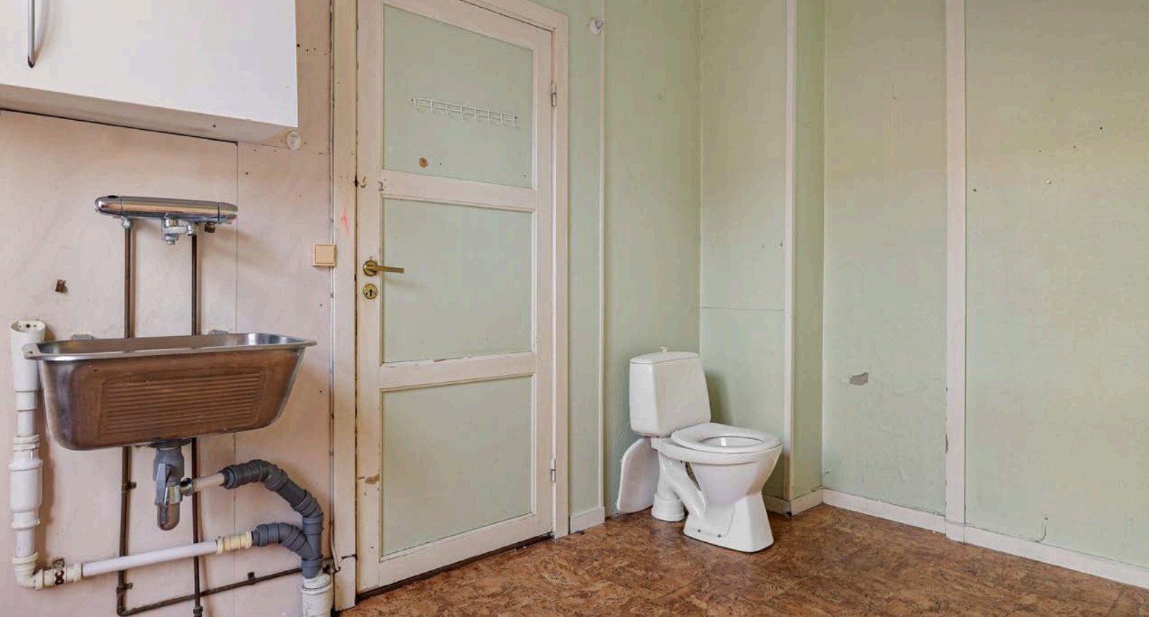
Rommer har utslagsvask, opplegg for vaskemaskin og gulvmontert toalett.
