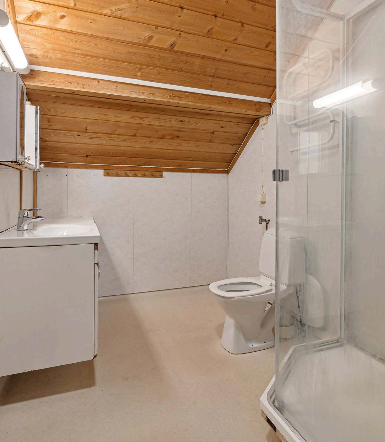
Bad i loftetasjen med belegg på gulvet og våtromsplater på veggene.
