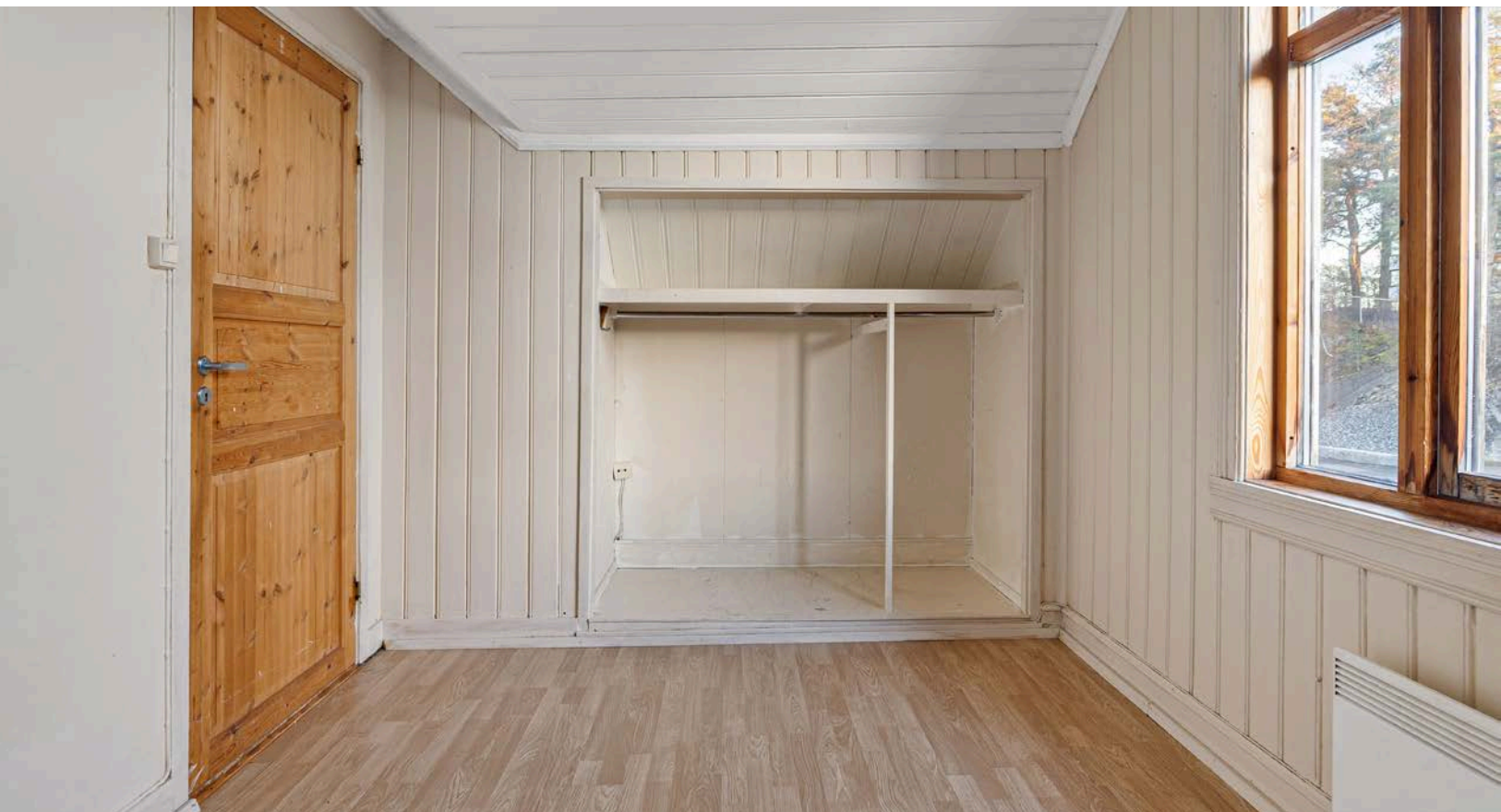
På dette rommer er det laget en garderoberisje i kneveggen.
