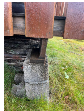
Enkel fundament med vridning
