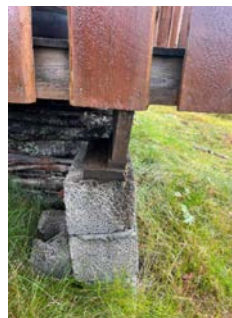
Enkel fundament med vridning
