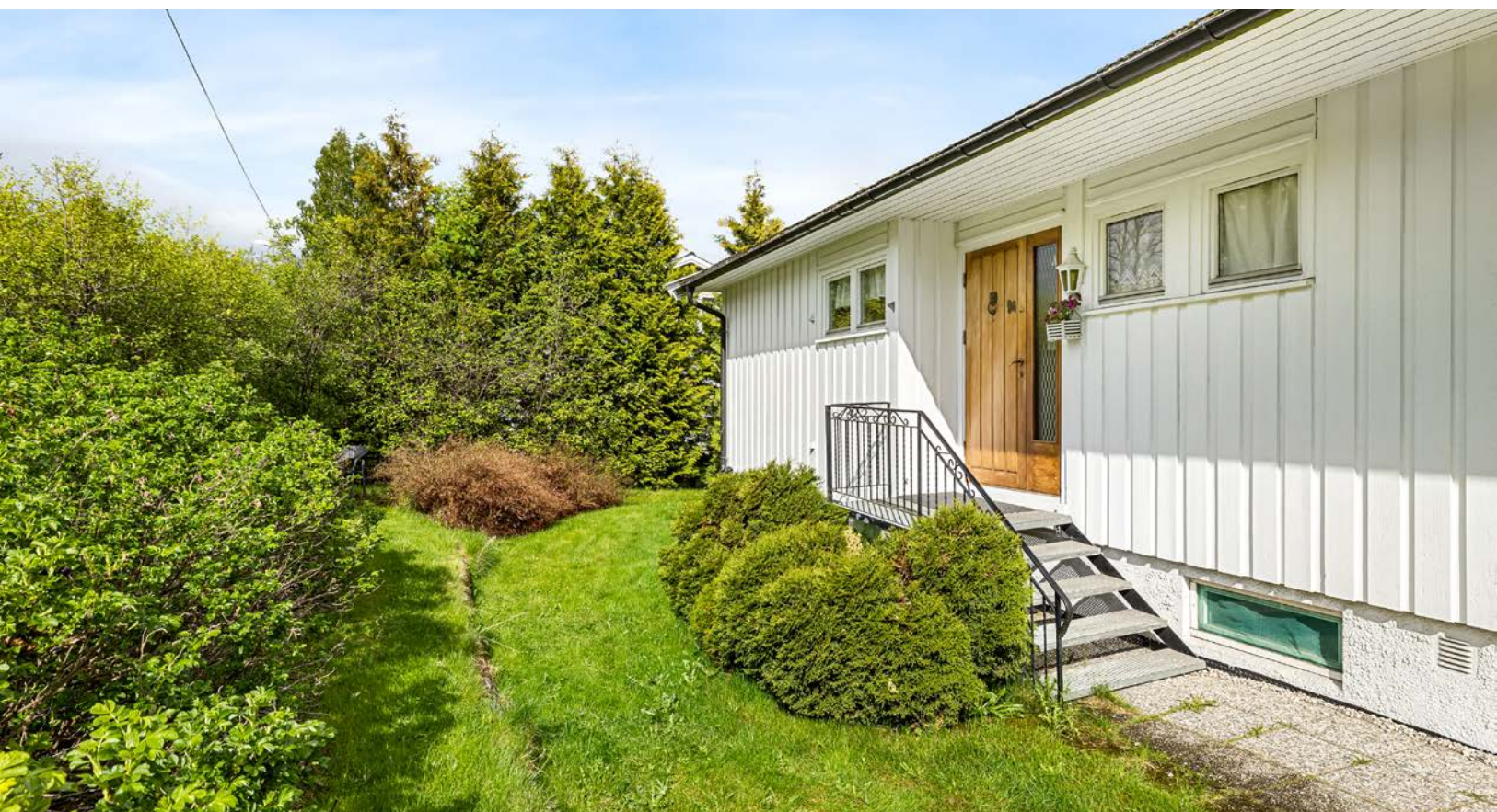
Inngangsparti til boligen via utvendig trapp på baksiden.
