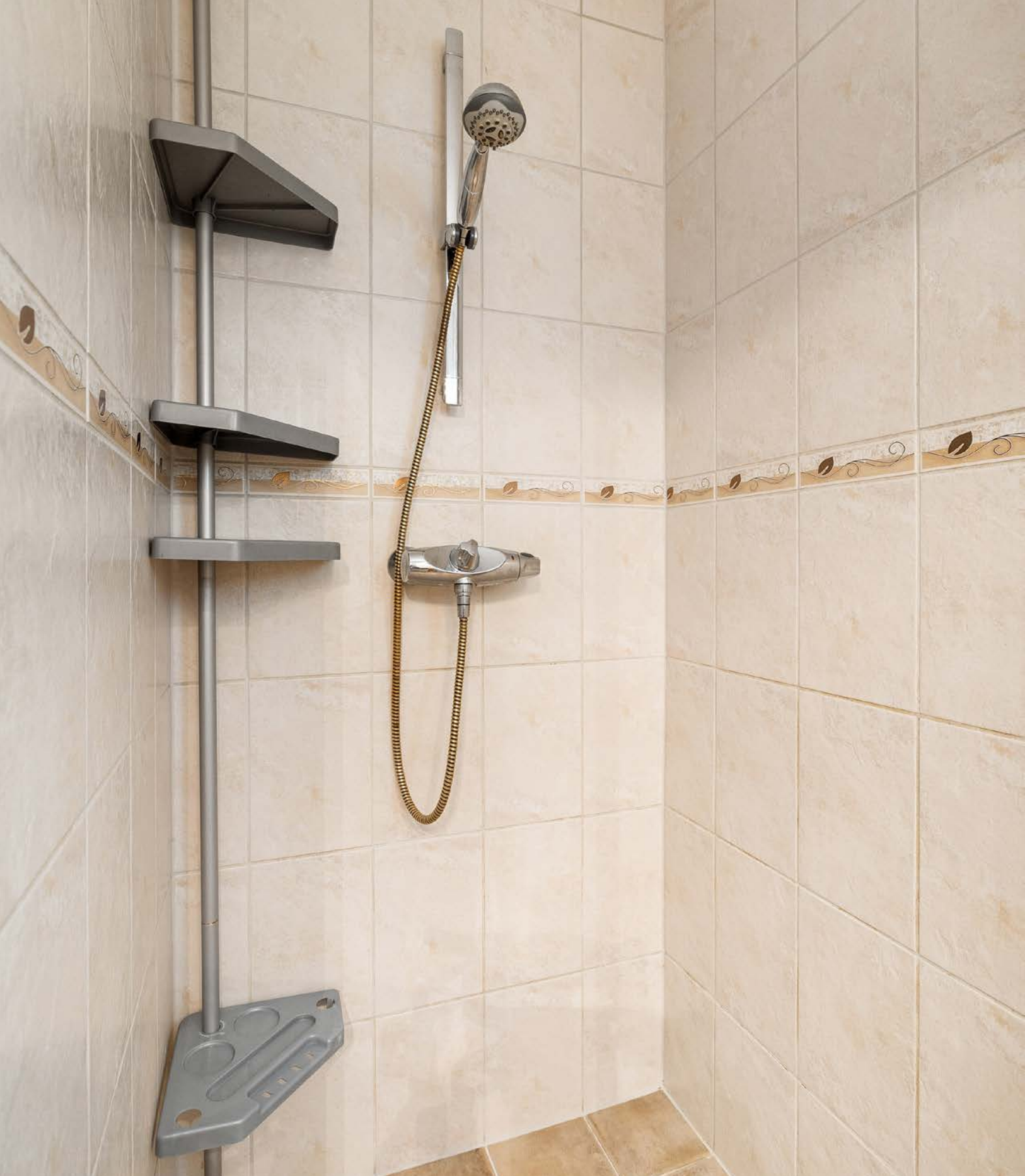
Dusjhjørne med dusjgarnityr på vegg.
