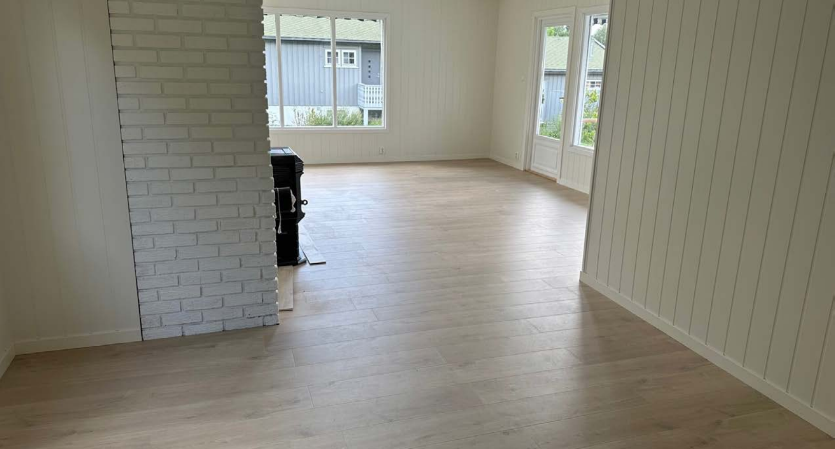
Stuen er pusset opp med nytt gulv og plater på vegger.
