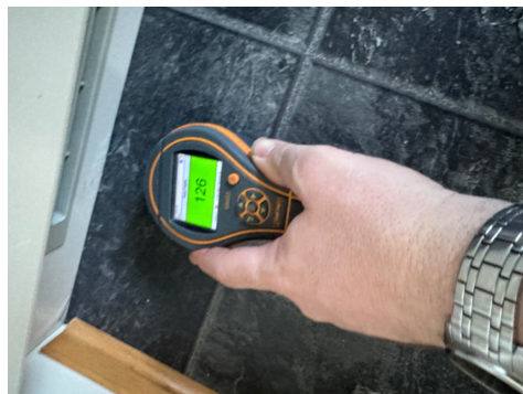
Foto viser overflatesøk på overflater, relativt like verdier på befaringsdagen.
