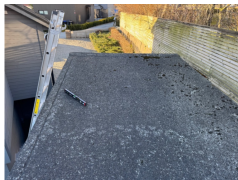
Foto viser tak på garasje og forstøtningsmur med rekkverk mot nabo.
