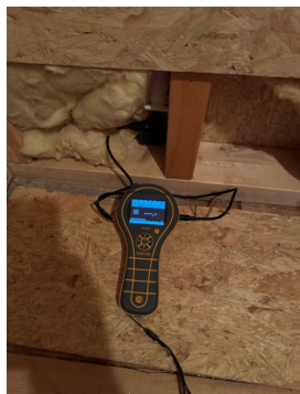
Foto viser fuktmåling i lukket konstruksjon bak dusj.
