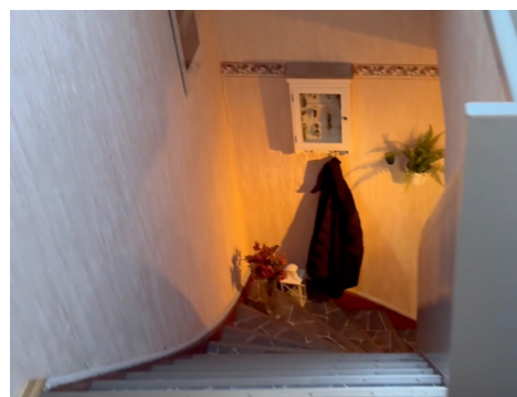
Foto viser innvendig trapp mellom 1. og 2. etasje.
