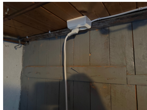
Foto viser tank tilknyttet stikk i tak.
