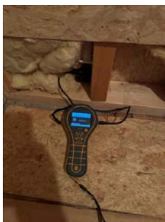
Foto viser fuktmåling i lukket konstruksjon bak dusj.
