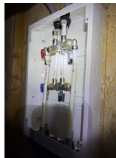
Foto viser rørskap for rør-i-rør system.
