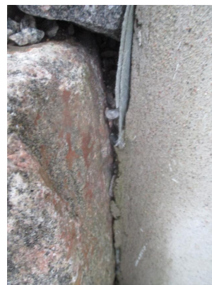
Deler av fuktsikring er synlig.
