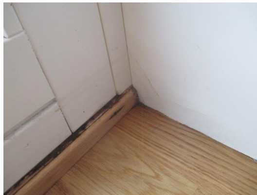
Foring av mdf har svellet ved skyvedør i tv.stue.
