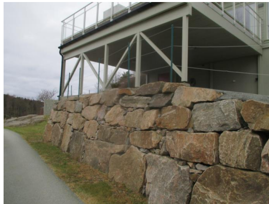
Maskinstablet forstøtningsmur i mot vei.
