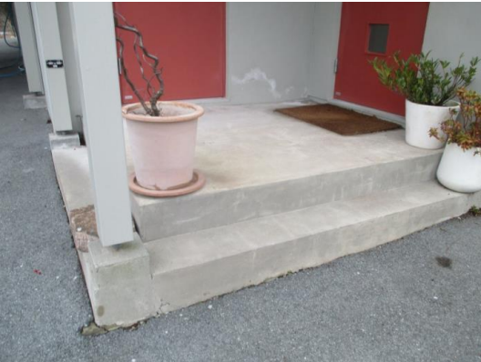
Støpt plattning ved inngangsparti.
