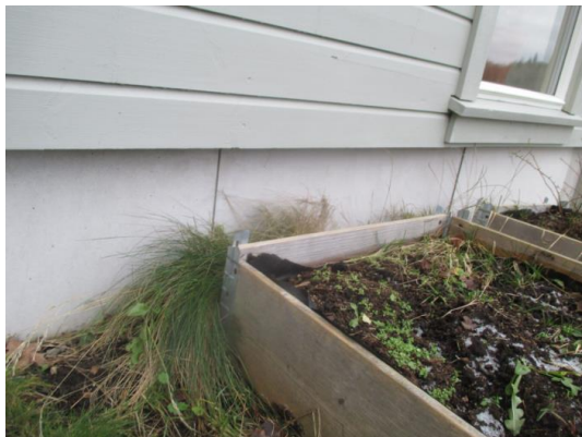
Ringmur av isolerte ringmurselementer.
