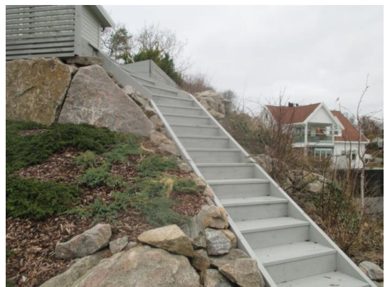
Ny trapp langs bakkenivå.
