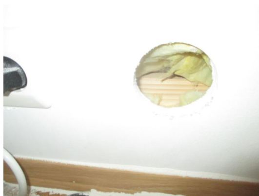
Hulltaking i fra soverom.
