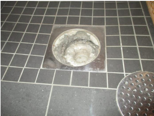
Sluk ved teknisk del.
