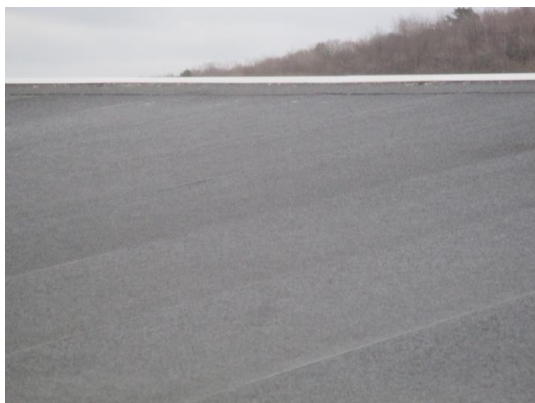
Deler av taktekkingen.
