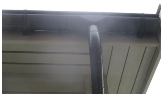
Takrenner og nedløp.
