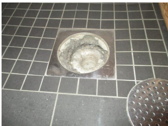
Sluk ved teknisk del.
