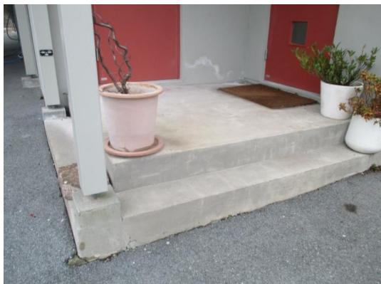
Støpt platting ved inngangsparti.
