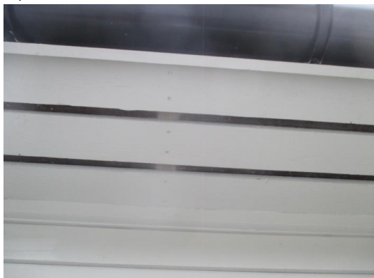
Luftespalter i gesimser.
