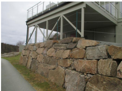
Maskinstablet forstøtningsmur i mot vei.
