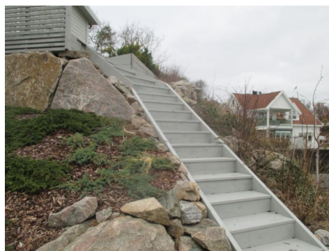
Ny trapp langs bakkenivå.
