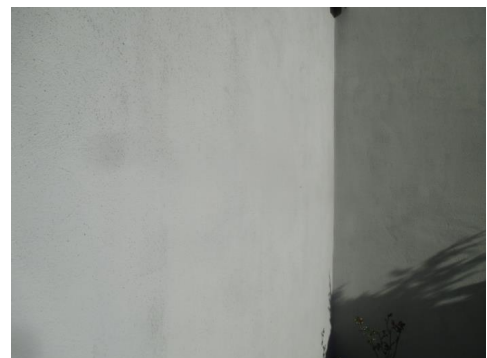
Deler av pusset grunnmur.
