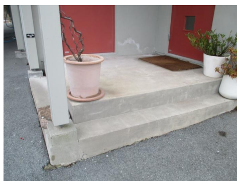
Støpt platting ved inngangsparti.
