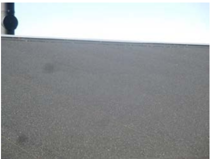
Deler av taktekkingen.
