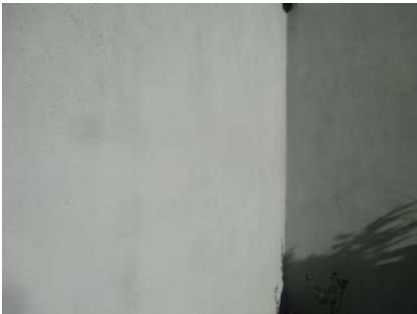
Deler av pusset grunnmur.
