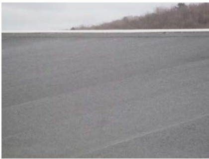
Deler av taktekkingen.
