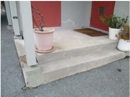
Støpt platting ved inngangsparti.
