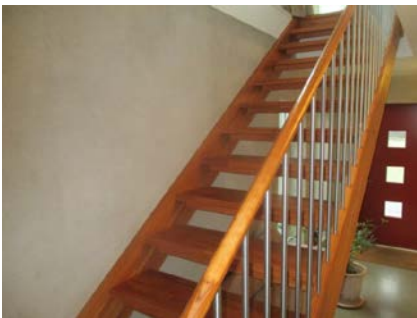
Trapp med åpne opptrinn.
