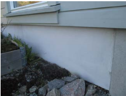
Deler av ringmur.
