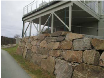
Maskinstablet forstøttningsmur i mot vei.
