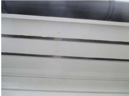
Luftespalter i gesimser.
