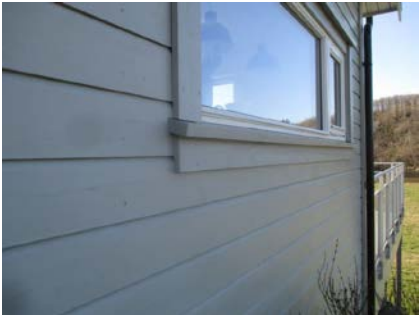
Deler av kledningen med tilhørende belistninger.
