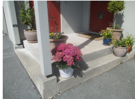
Støpt platting ved inngangsparti
