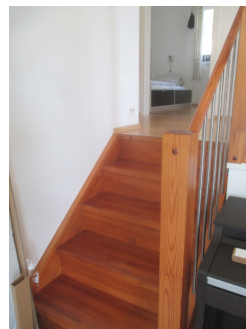
Mindre trapp med tette opptrinn til øverste etasje
