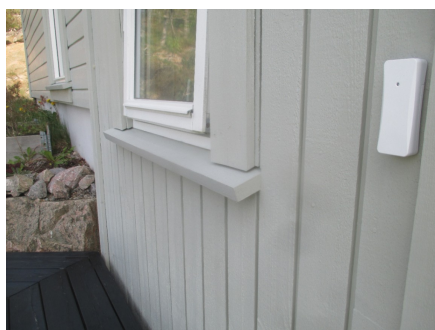
Deler av kledningen med tilhørende belistninger
