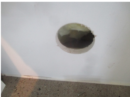
Hulltaking fra skyvedørsgarderobe i hallen.
