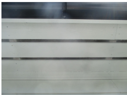
Luftespalter i gesimser.
