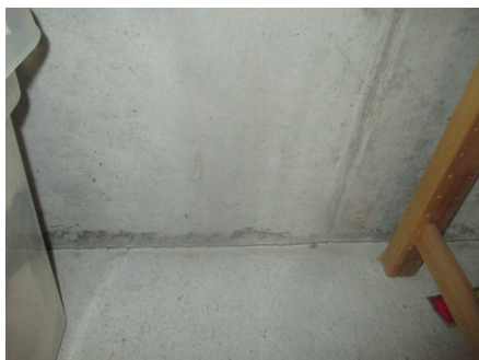
Synlige støpt grunnmur i bod/lagerrom.
