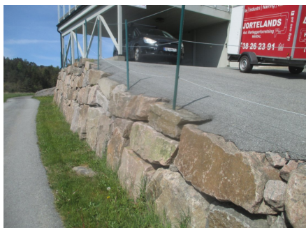
Deler av forstøtningsmur
