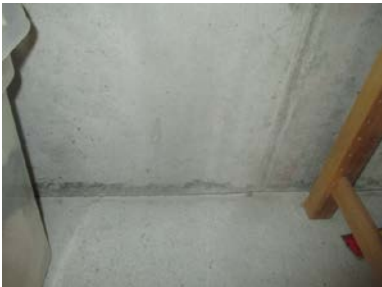
Synlige støpt grunnmur i bod/lagerrom.
