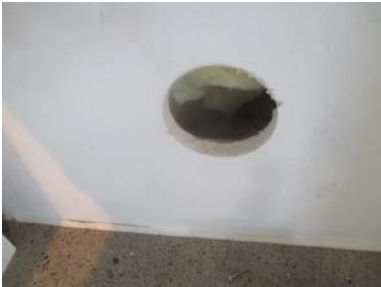
Hulltaking fra skyvedørgarderobe i hallen.
