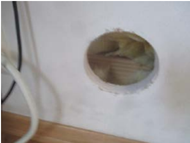
Hulltaking fra soverommet.
