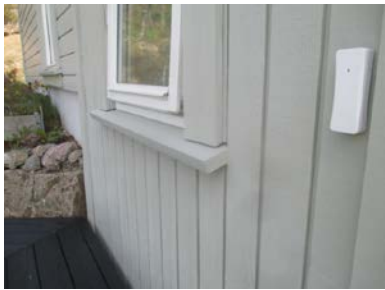
Deler av kledningen med tilhørende belistninger
