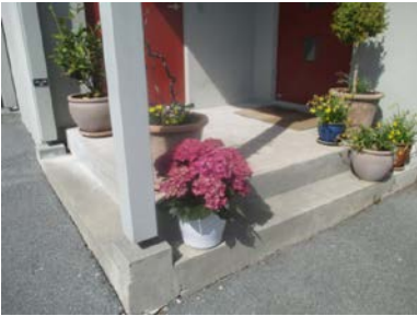
Støpt platting ved inngangsparti
