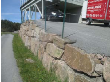
Deler av forstøttningsmur
