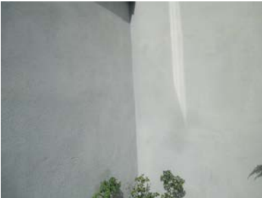
Deler av pusset grunnmur
