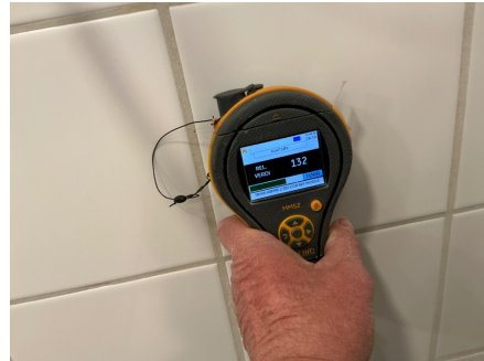
Ved fukt-søk under blandedbatteri er det ikke registrert unormale verdier.
