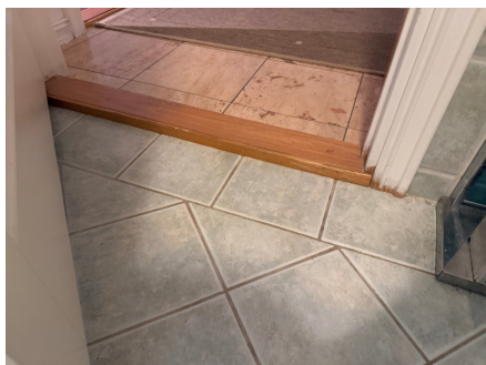
Usikkert om det er membran oppkant bak list.
