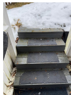
Vedlikeholdsbehov av trapp ved adkomst til separat del io u. etg.
