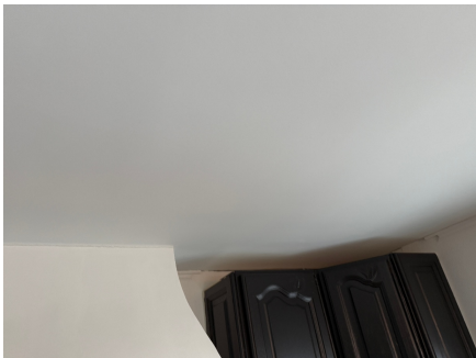
Gjenstående listearbeider i tak på kjøkken.
