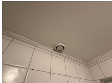
Hull etter oppheng. Anbefales tettet med silikon.
