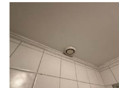
Hull etter oppheng. Anbefales tettet med silicon.
