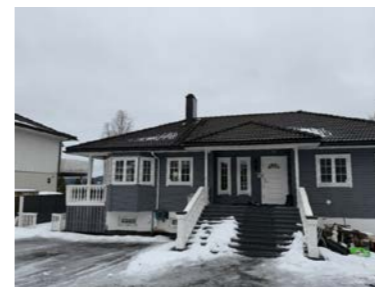
Trapp ved adkomst. Vedlikeholdsbehov av rekkverk.
