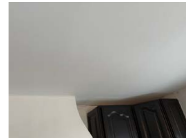
Gjenstående listearbeider i tak på kjøkken.
