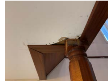
Noe gjenstående arbeider rundt søyle ved trapp hovedel u. etg.
