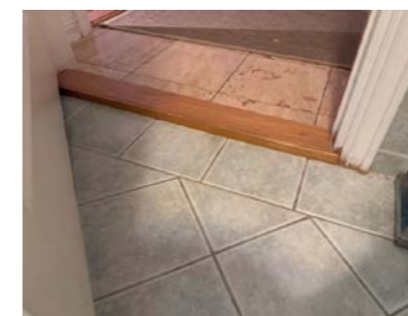
Usikkert om det er membran oppkant bak list.
