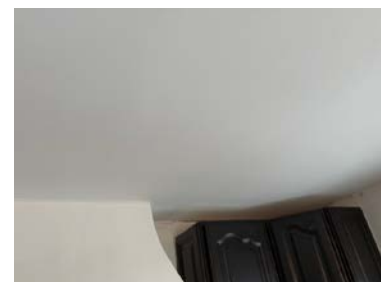
Gjenstående listearbeider i tak på kjøkken.
