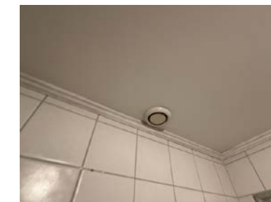
Hull etter oppheng. Anbefales tettet med silicon.
