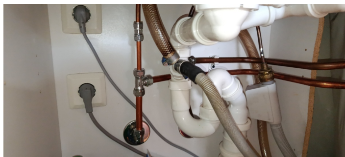
Kontroll av røropplegg.
