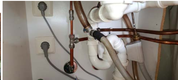
Kontroll av røropplegg.
