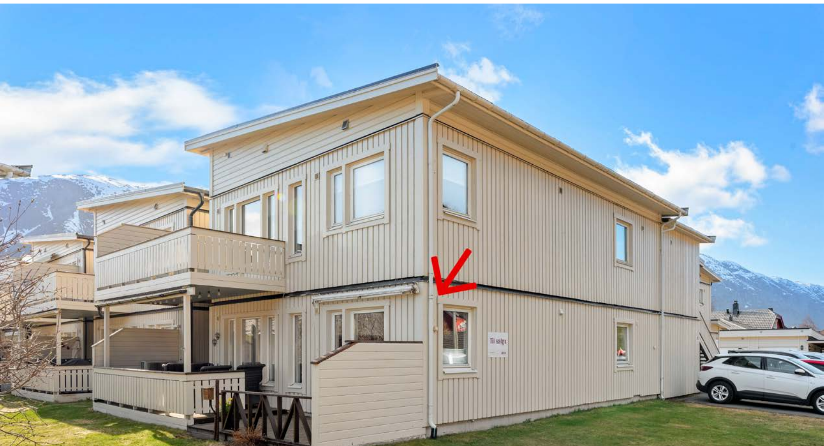
Fasade mot Austerbygdvegen
