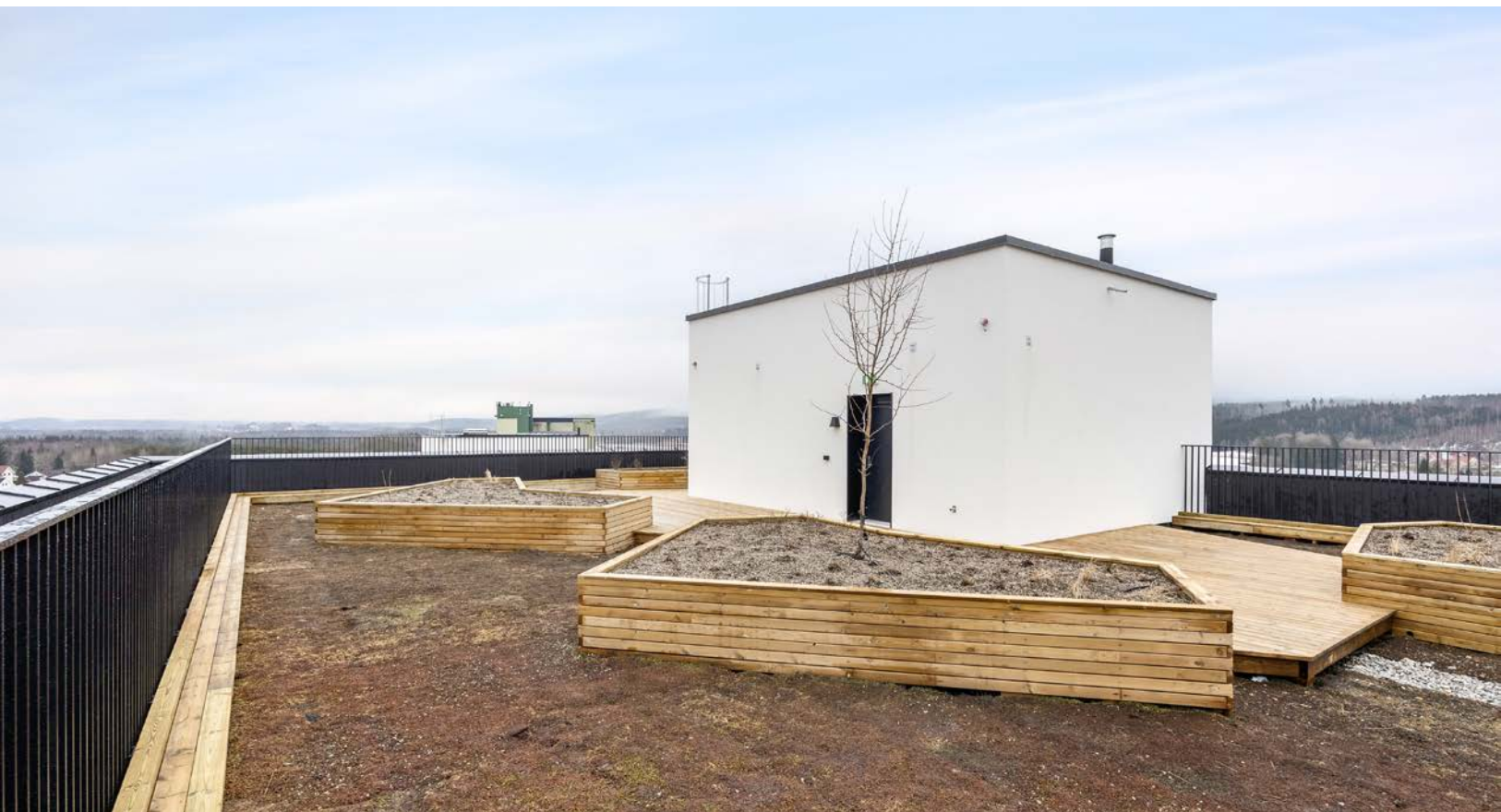
På takterrassen er det blomsterkasser med småtrær og det er sedum på taket - som gir et hyggelig miljø
