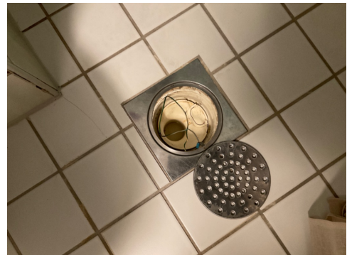
Eldre plastsluk, sluk forlengelse, ukjent løsning
