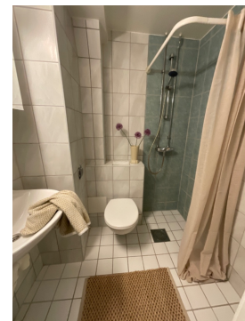
Eldre plastsluk, sluk forlengelse, ukjent løsning
