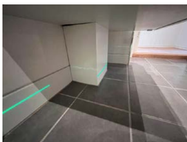
Rørgjennomføring i gulv ikke kontrollert
