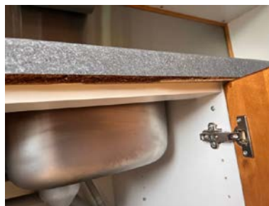
Skade på benkeplate
