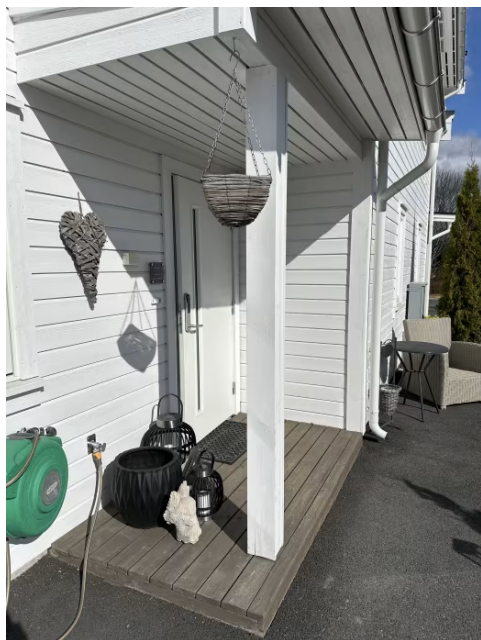
Overbygget platting ved inngangsparti.
