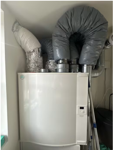
Viser ventilasjonsaggregat.
