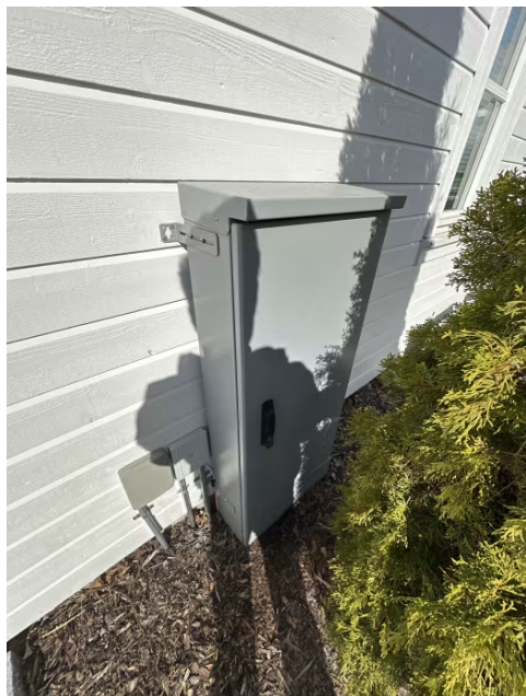
Viser utvendig målerskap. Felles skap med nabo.
