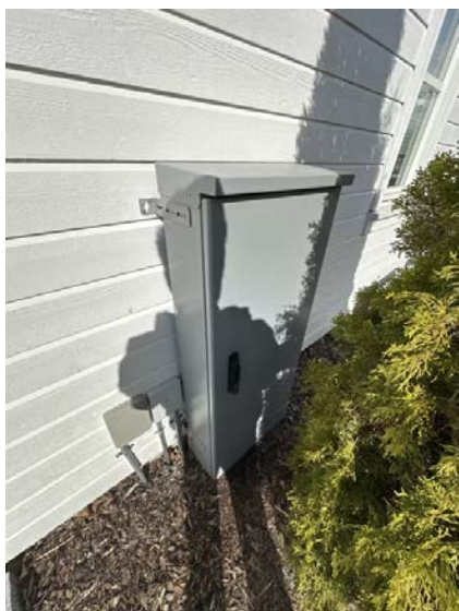
Viser utvendig målerskap. Felles skap med nabo.
