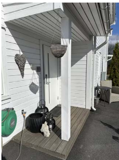
Overbygget platting ved inngangsparti.
