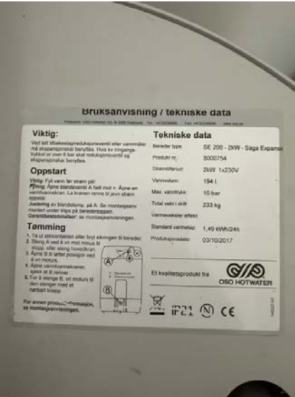
Viser teknisk data på bereder.
