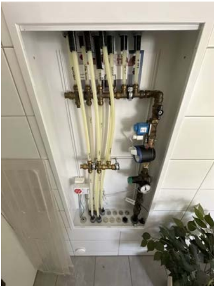
Vannrør med rør i rør system fra fordelerskap plassert på bad.
