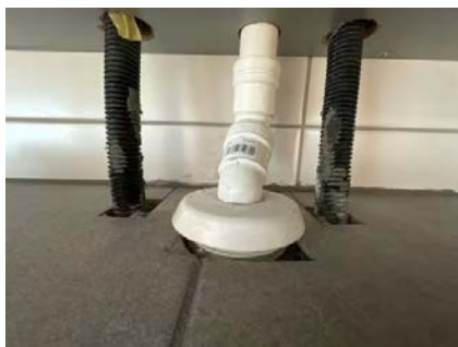
Rørføringer gjennom gulv har ikke synlig membran / mansjetter over gulvet.
